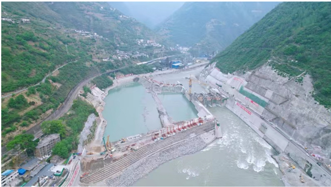
7月10日，中国能建葛洲坝市政公司承建的沙坪一级水电站二期围堰防渗墙完工，比计划施工时间提前了13天。沙坪一级水电站位于乐山市金口河区境内，是四川省“十四五”重点建设项目和贯穿四川省大渡河水能能源主线的重点阶段梯电站。电站总装机容量360兆瓦，多年平均发电量16.35亿千瓦时。彭捷 蔡森 摄影报道
