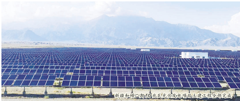
新疆和硕二期50兆瓦光伏发电项目土建工程全部完成
