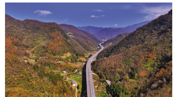
铜钱峡村特大桥
