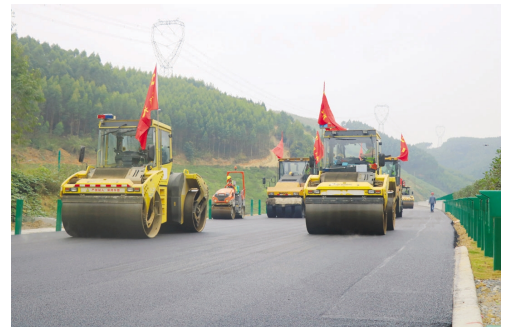
沥青摊铺现场
