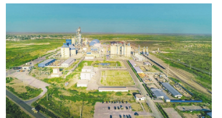
哈萨克斯坦西里水泥项目航拍
